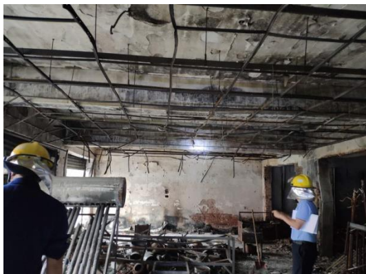
图 12 一层门厅处烧损情况 图 13 一层南侧外部两侧出口被封闭
