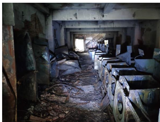
图 10 一层东侧房间底部烧损情况 图 11 一层西侧过火后烧损情况
