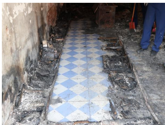
图 10 一层东侧房间底部烧损情况 图 11 一层西侧过火后烧损情况
