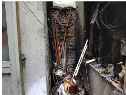
图 12 一层门厅处烧损情况 图 13 一层南侧外部两侧出口被封闭
