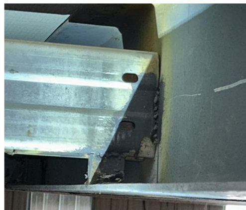
图 17 双拼 C160 卷边槽钢次梁与主钢梁连接
