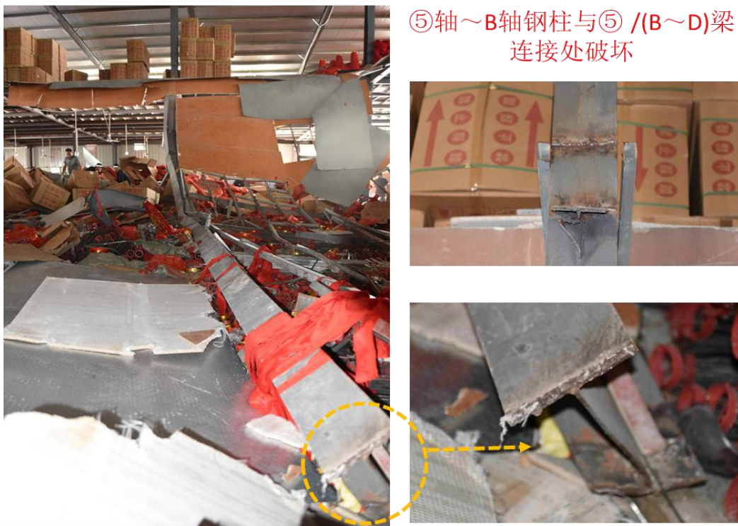
图 13 5/(B~D)梁破坏现场图
