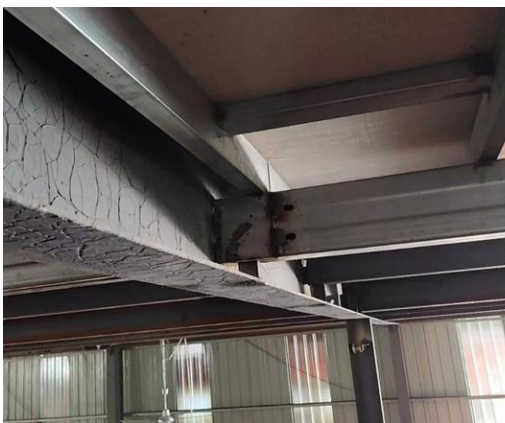
图 17 双拼 C160 卷边槽钢次梁与主钢梁连接
